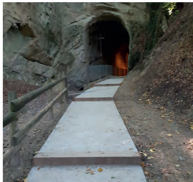
Instandsetzung der Treppen und der Brücke des Ritterwegs.
