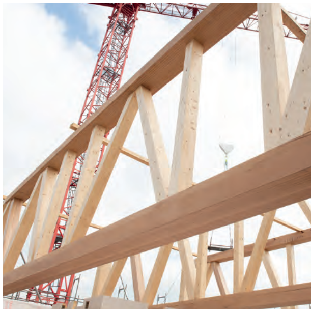
Der Rohbau Batpol
